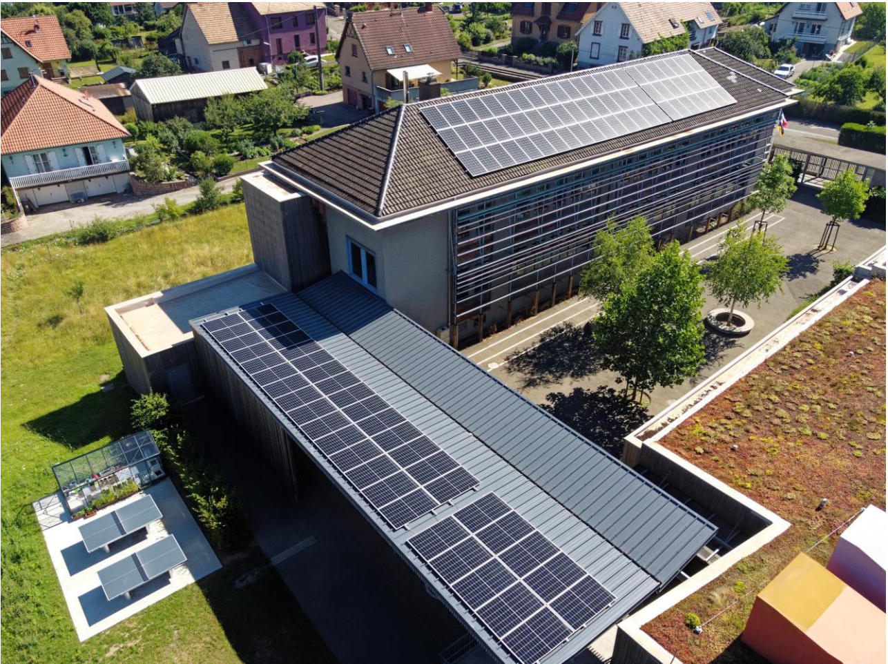
Installation de 36 kWc sur les toits de l'école de Dossenheim-sur-Zinsel
